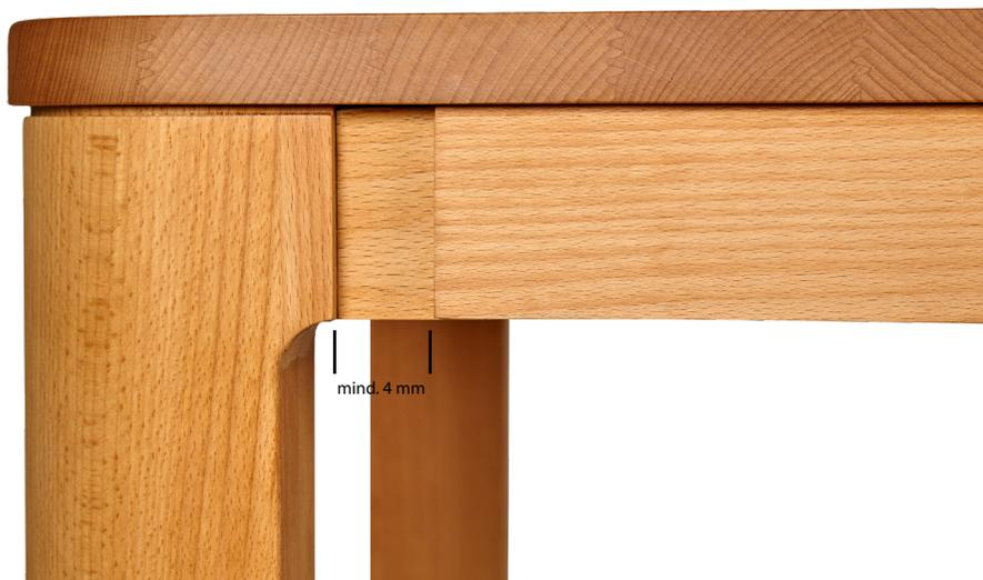
**7.** Dank einer Dehnungsfuge kann das Holz bei schwankender Luftfeuchtigkeit arbeiten, ohne Schaden zu nehmen. Sollte (bei steigender Luftfeuchtigkeit und quellendem Holz) die Fuge schmäler als 4 mm werden: die Plattenverbinder vorübergehend entfernen, bis die Fuge wieder mindestens 4 mm breit ist.
